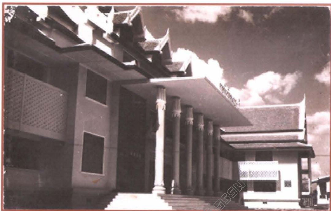
ศาลจังหวัดสุพรรณบุรีและศาลแขวงสุพรรณบุรี ก่อสร้างและปรับพื้นที่รอบอาคาร ก่อนวันพิธีเปิดทำการอย่างเป็นทางการ วันที่ ๑๖ กุมภาพันธ์ พ.ศ. ๒๕๐๕
