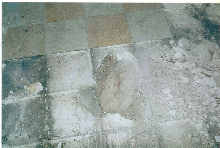
พื้นโครงสร้างคอนกรีตเสริมไม้
