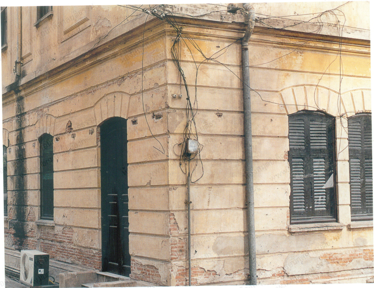
มุมอาคารชั้นล่าง
