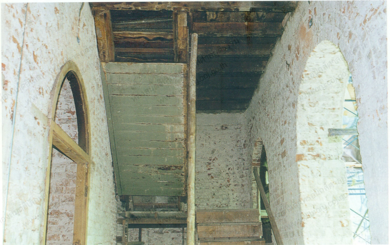
โครงสร้างผนังรับน้ำหนัก
