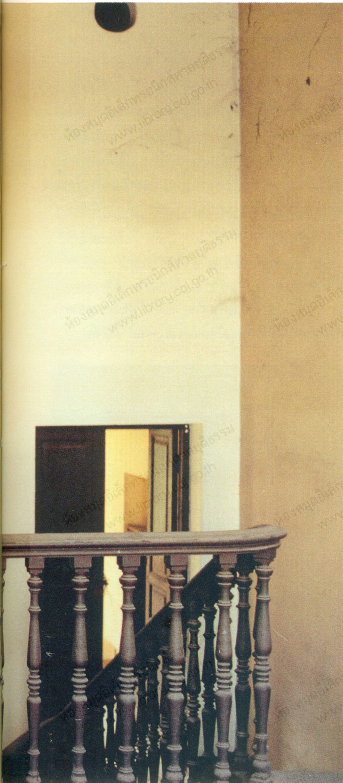
บันไดทางขึ้น
