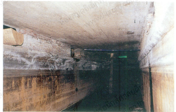
ฐานรากได้อาคาร
