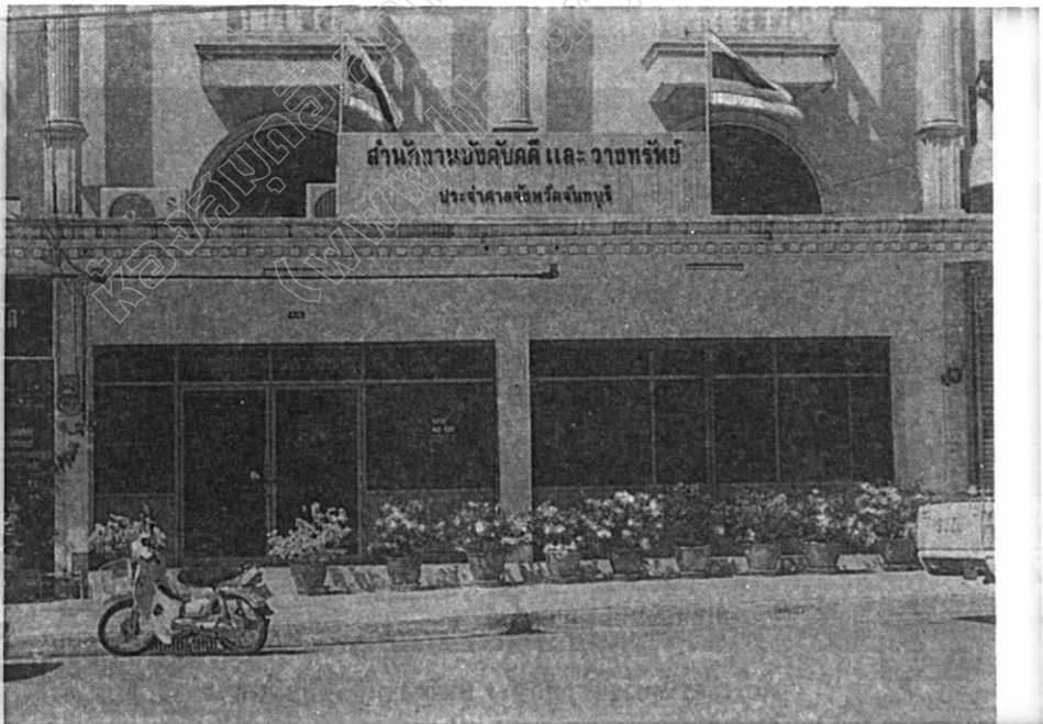
ตึกแถวซึ่งสำนักงานบังคับคดีฯ เข้าเป็นสำนักงาน เนื่องจากยังมิได้รับงบประมาณก่อสร้างสำนักงานอย่างถาวร
