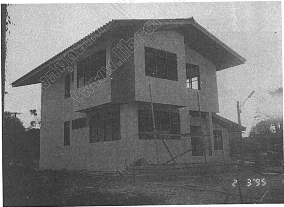
บ้านพักผู้พิพากษาที่กำลังก่อสร้าง
