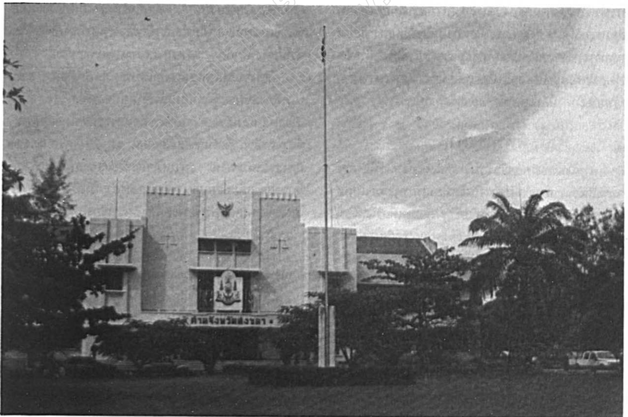
ศาลจังหวัดสงขลา (อาคารเดิม)
