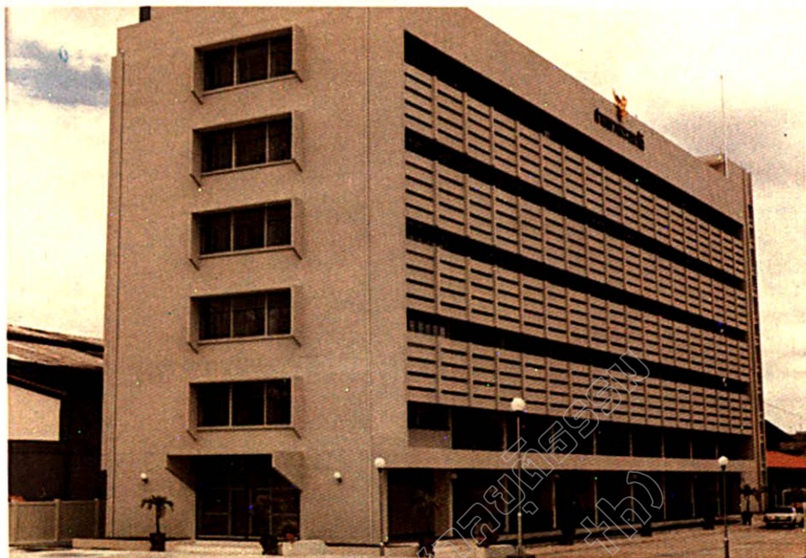
อาคารที่ทำการหลังใหม่ศาลแขวงพระนครใต้
