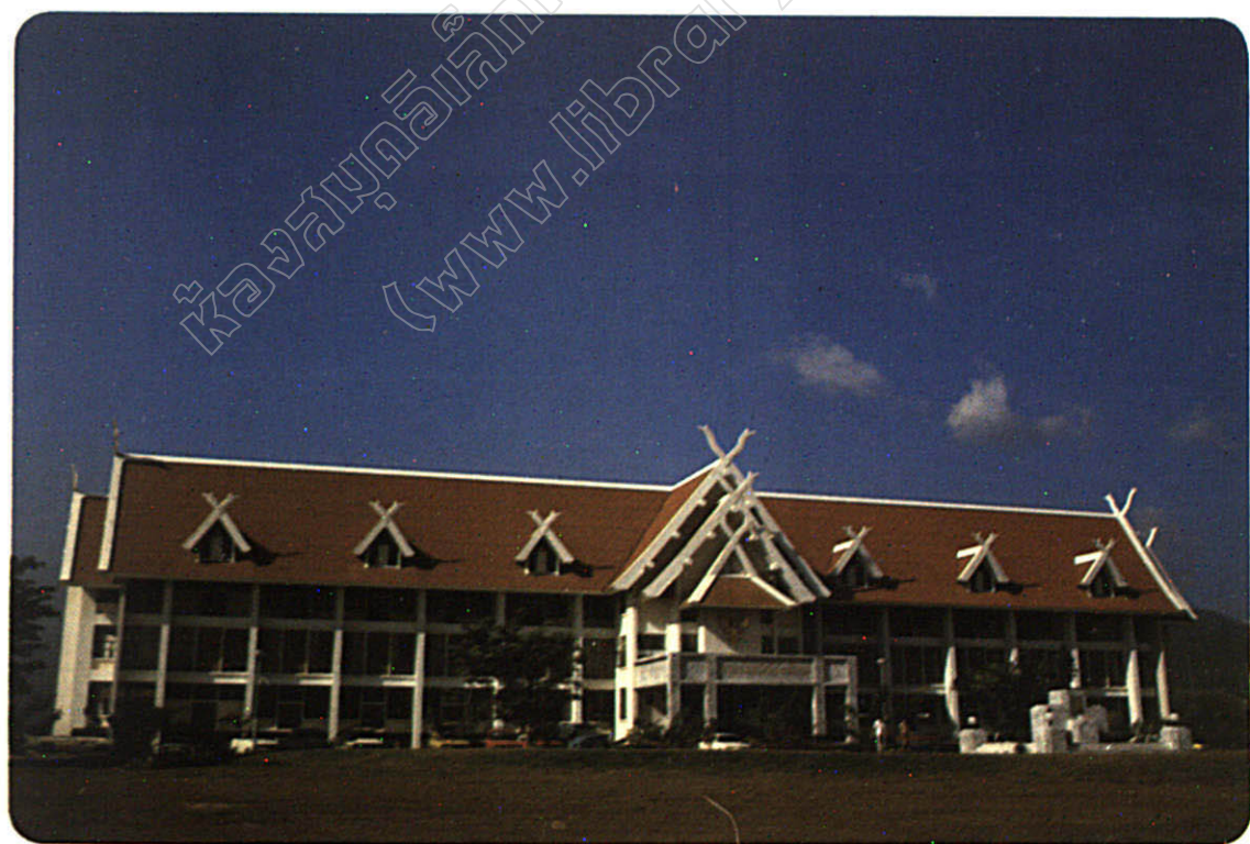
อาคารศาลจังหวัดเชียงใหม่หลังใหม่
