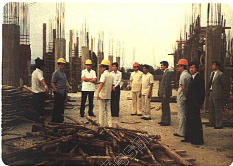
ฯพณฯ มาร์ต บูนาค รัฐมนตรีว่าการกระทรวงยุติธรรม ตรวจการก่อสร้างอาคาร ศาล จังหวัดเชียงใหม่
