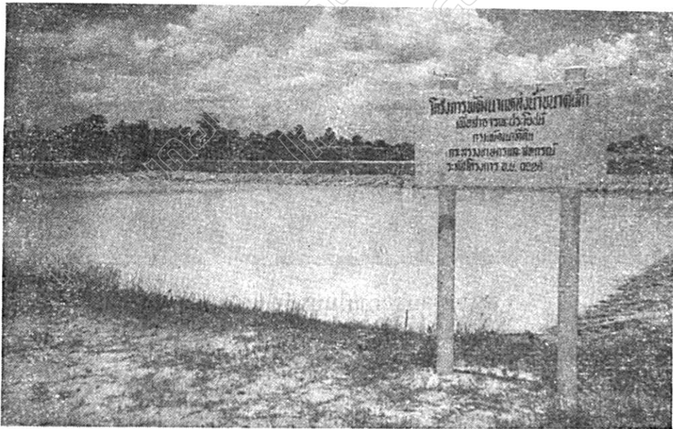
สระเก็บน้ำ ขนาด ๔๐ x ๑๐๐ เมตร ลึก ๔ เมตร
