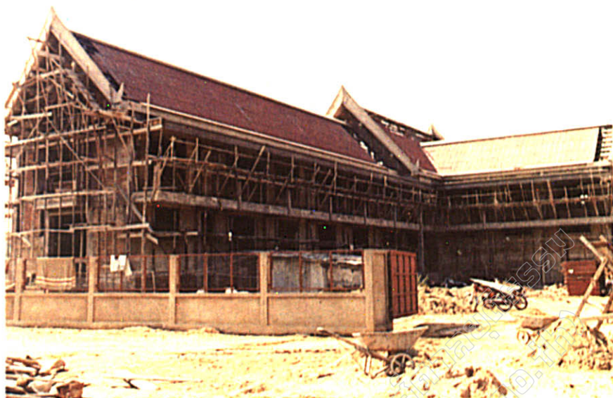
อาคารศาลจังหวัดลำพูนก่อสร้างใกล้เสร็จ
