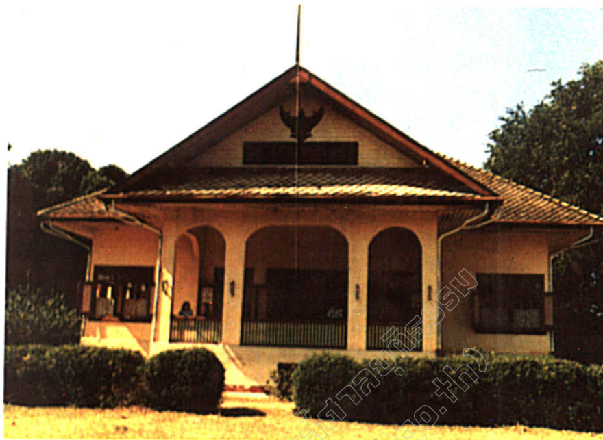
อาคารศาลจังหวัดลำพูนหลังเก่า
