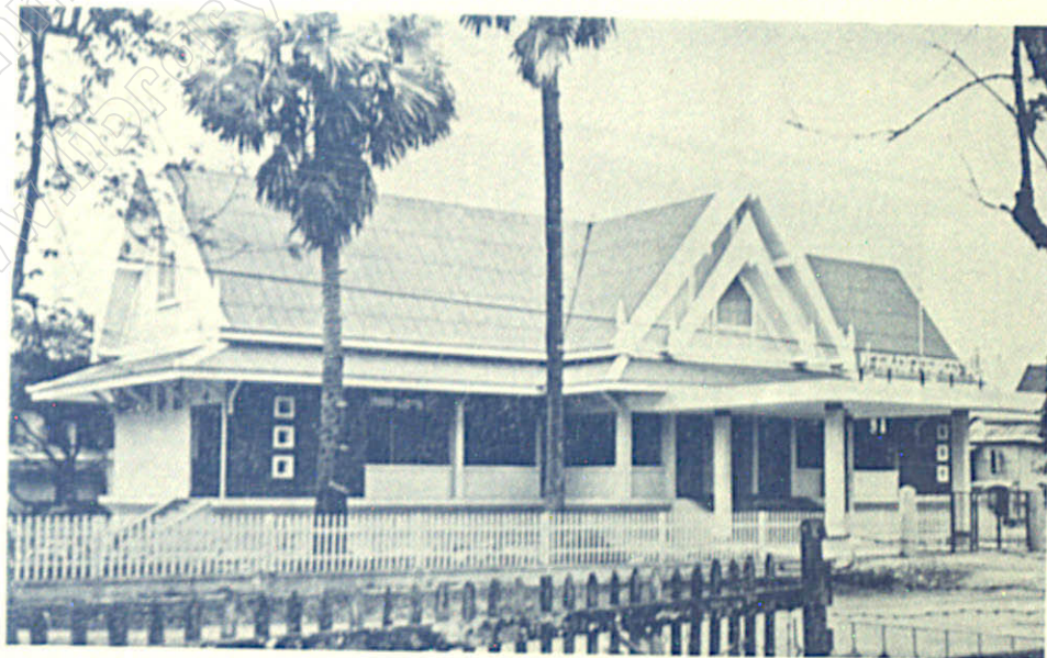
อาคารที่ทำการศาลแขวงอุตรธานี (หลังใหม่)
