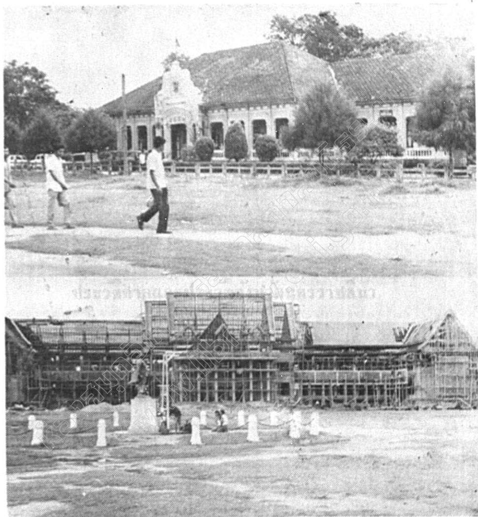
(บน) ศาลเก่าซึ่งขณะนี้รื้อไปแล้ว (ล่าง) ศาลใหม่ขณะกำลังก่อสร้าง
