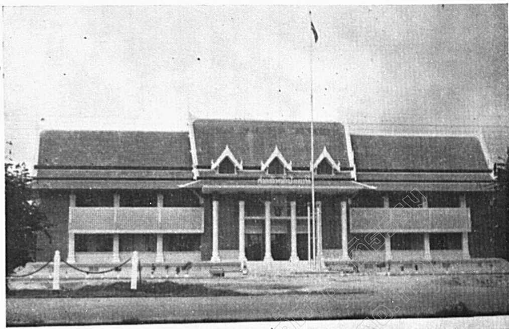
อาคารศาลจังหวัดปัตตานี ที่ก่อสร้างใหม่
