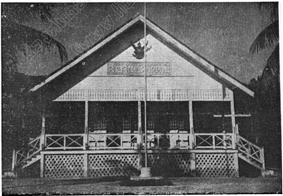
อาคารศาลจังหวัดปัตตานีหลังเดิม
